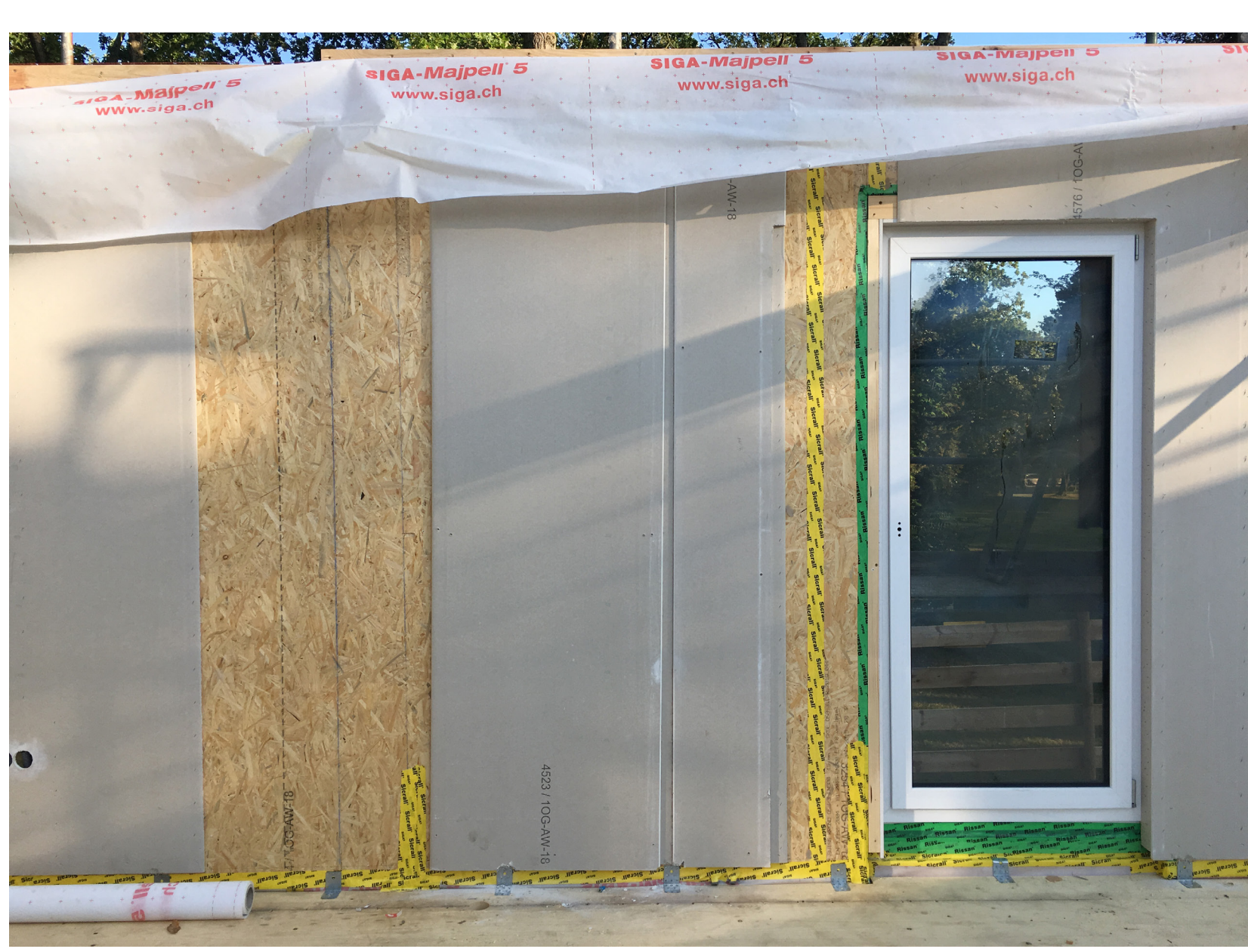
Ökonomische Bauausführung (kurze Bauzeit, hohe Qualität)
