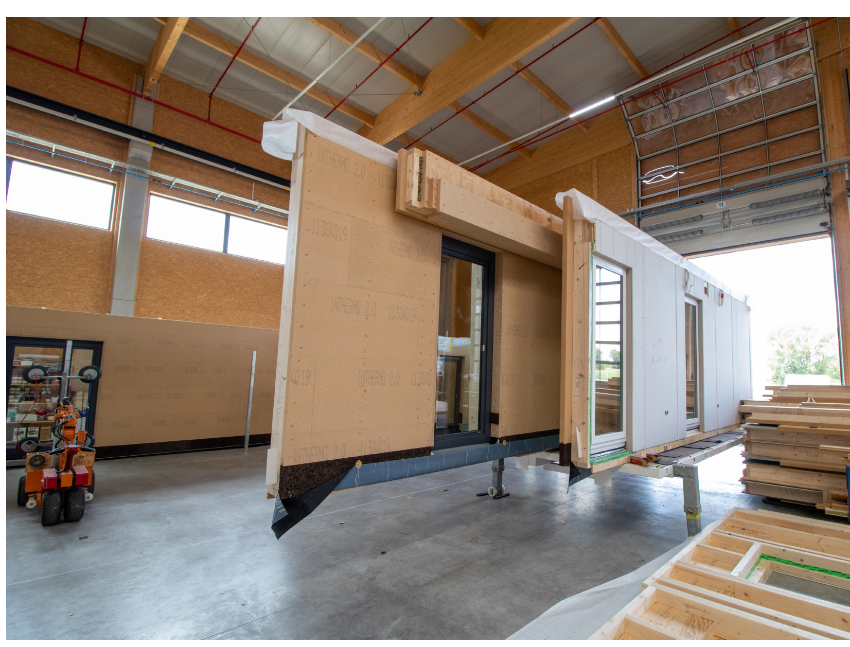
Vorfabrizierung im Werk
