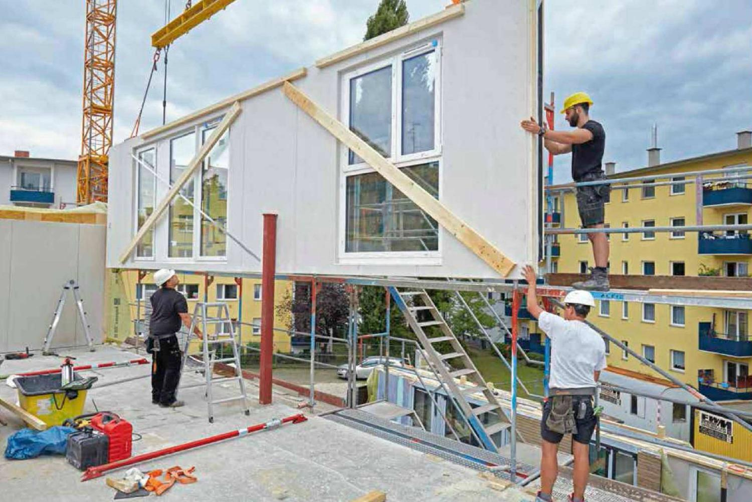
▲ Vorgefertigt und schon mit eingebauten Fenstern schwebten die Wandelemente ein
