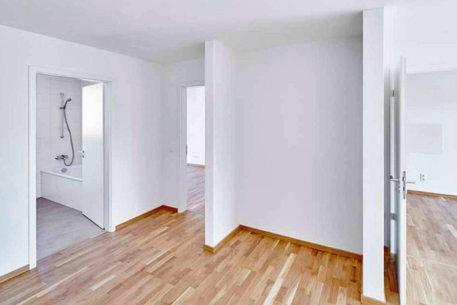
▲ Aus Brandschutzgründen sind die Holzmassivbauwände gekapselt worden
